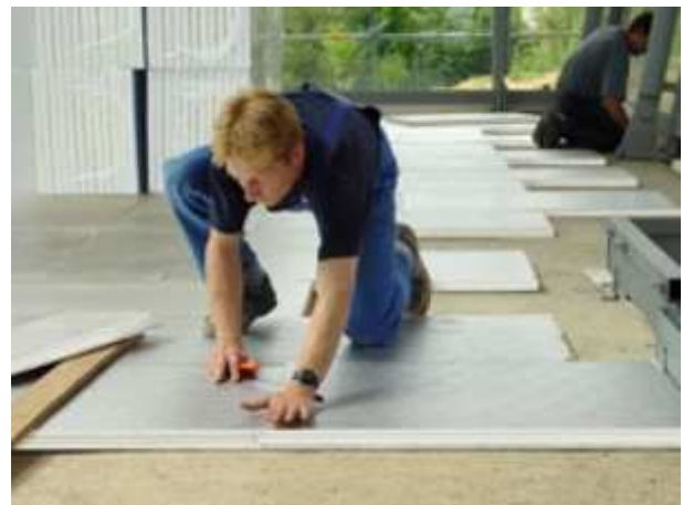
Pose de polyuréthane en panneaux
