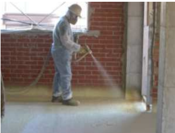
Mise en œuvre de polyuréthane projeté
