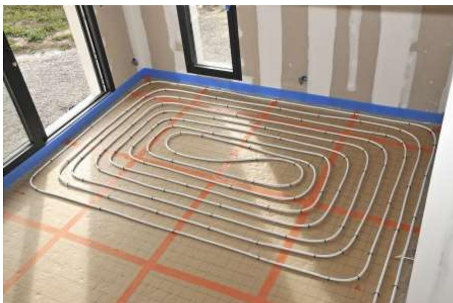
*Les systèmes de chauffage par le sol sont principalement des planchers chauffants/rafraîchissants basse température (PCRBT), composés d'un émetteur et de panneaux isolants.*
